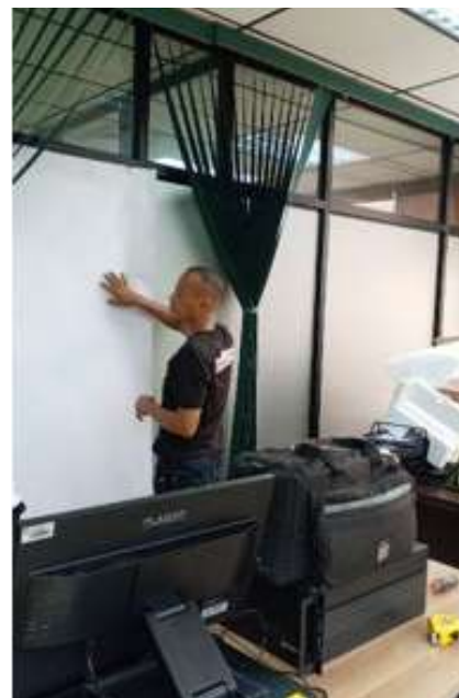
Instalación de papel esmerilado y nanocerámico en las direcciones de Ingeniería, Programación y en el Departamento de Imagen.
