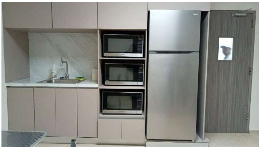
Remodelación de las cafeterías del tercer y segundo piso Sertv, Edificio Principal
