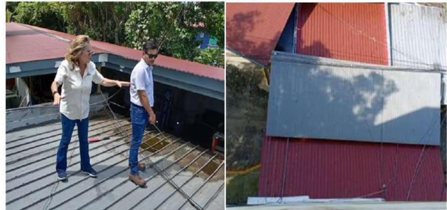
Cambio de techos en los cuartos de plantas eléctricas
