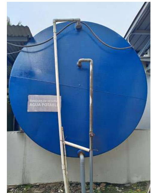
Mantenimiento y limpieza del tanque de reserva de agua potable.
