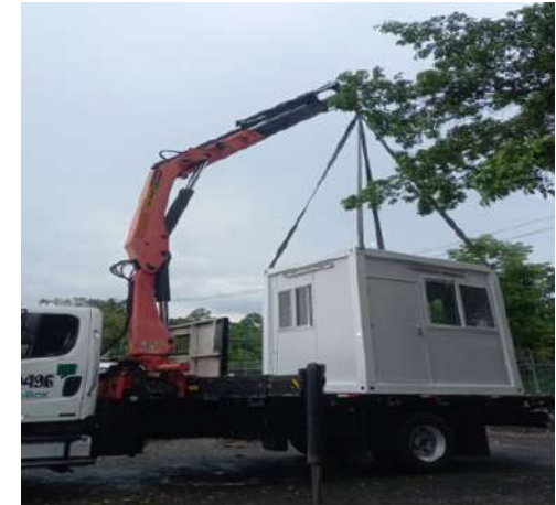
Suministro e instalación de contenedor (Garita de seguridad)
