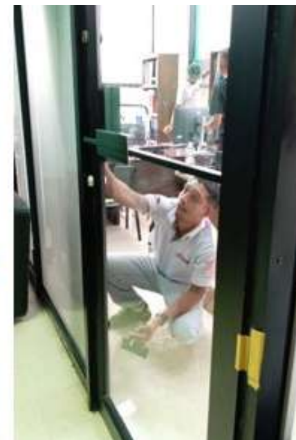
Instalación de papel esmerilado y nanocerámico en las direcciones de Ingeniería, Programación y en el Departamento de Imagen.
